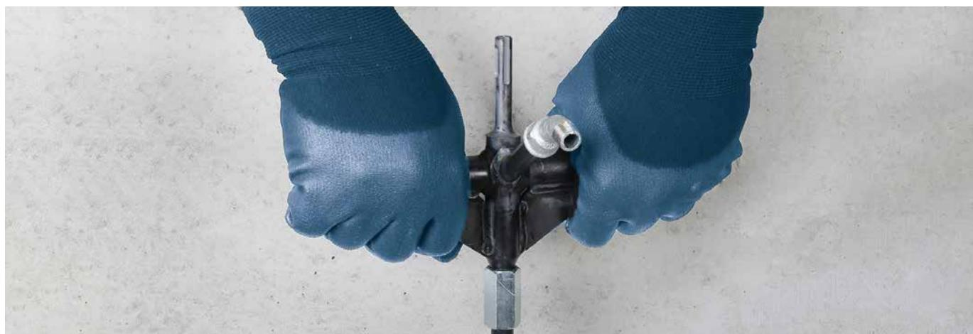
Bei kurzen Längen ist es möglich, die Rammverpresslanzen manuell am Griff zu ziehen. | Pour les longueurs courtes, il est possible de tirer les lances d'injection manuellement par la poignée.
